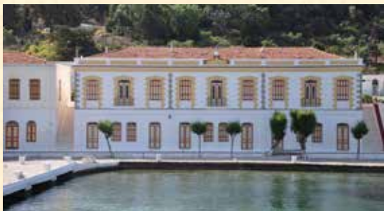
Γεν. άποψη τῆς μιᾶς πτέρυγας τῶν Καλυμνίκων.
